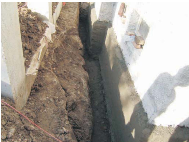
Tencuiala de protecție din mortar de ciment
