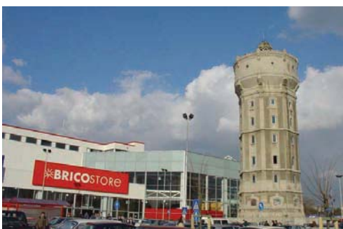
Foto 5: Vedere cu fațada clădirii
