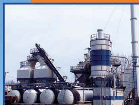
STATIE MIXTURI ASFALTICE
