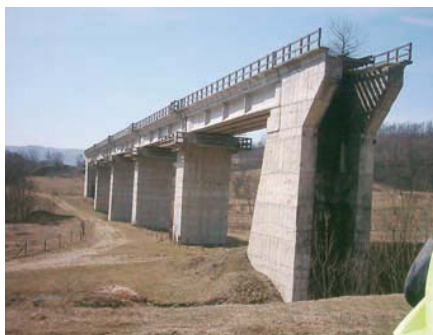
Foto 3: Viaduct existent la care se face alungirea unui viaduct cu noi deschideri
