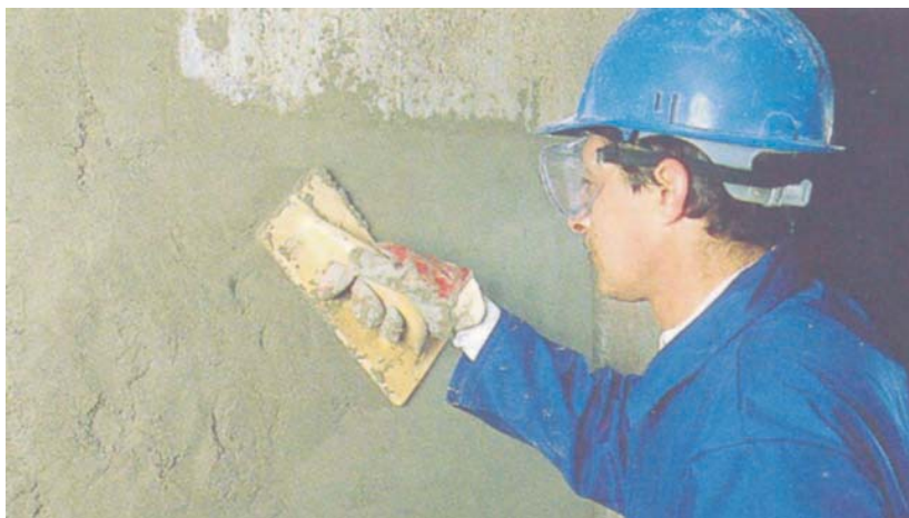
Aplicarea mortarului Integra
