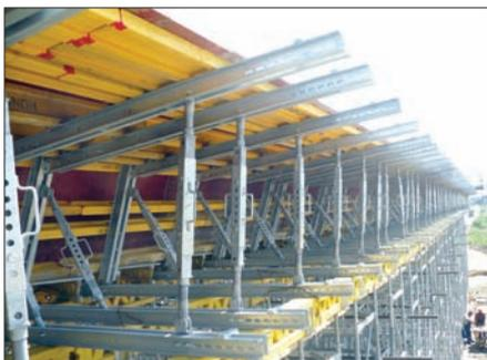
Fiind format din elemente metalice din oțel zincat, sistemul SG are o durată lungă de viață. În aceste condiții, se pretează foarte bine la închiriere pentru diferite lucrări, modalitate practică în mod curent de către Hünnebeck Romania.
