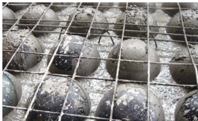
Foto 1: Folosirea betonului autocompactant la planșeele Bubble Deck
