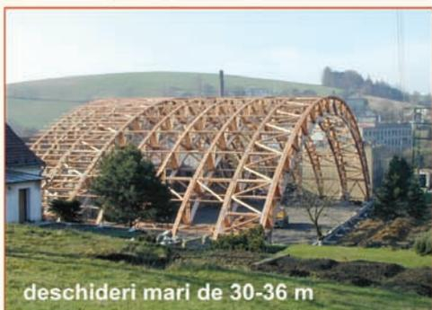
S.C. PASCONMAT CONSTRUCT SRL este soluția economică și eficientă în realizarea oricărui tip de construcție civilă, industrială și agricolă. Structurile din lemn tip sandwich permit o deschidere foarte mare (30-36 m), fiind recomandate în ridicarea halelor industriale și agricole.
