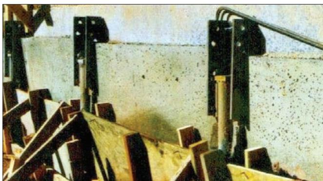
La fiecare 0,5 m de săpătură, se realizează un zid din beton armat, care se sprijină pe masa de pământ de sub construcția existentă.
