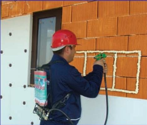
**Utilizări:** Fixarea plăcilor și profilelor din polistiren, la interior și exterior în sistemele de izolare termică. Lipirea stratului termoizolant din polistiren aferent sistemelor de izolare termică, realizate conform Ghidului European pentru Agrementarea Tehnică a Sistemelor de Izolare Termică Exterioară - ETAG 004:2000. Agrement tehnic AT 016-03 / 258-2008.
