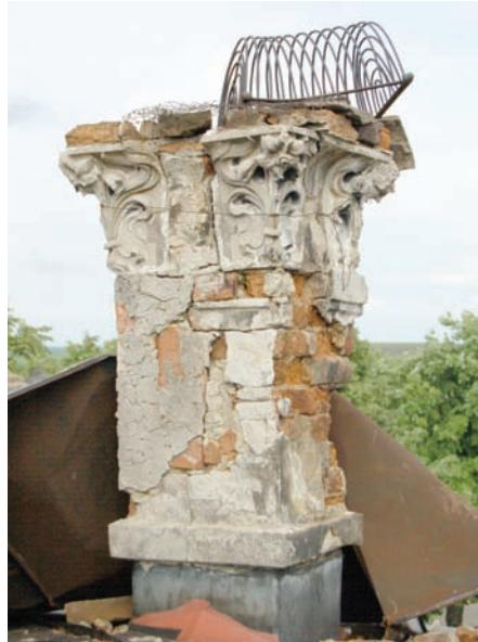
Foto 8: Detaliu ale degradărilor de la nivelul acoperișului
