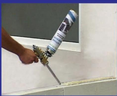
**Utilizări:** pentru fixarea diferitelor tipuri de piatră cum ar fi piatra naturală, BCA, rigips, cărămidă, atât pe interior cât și pe exterior, cu o excelentă aderență pe suprafete.
