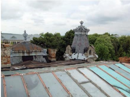
Foto 7: Vedere de ansamblu asupra degradărilor de la nivelul acoperișului
