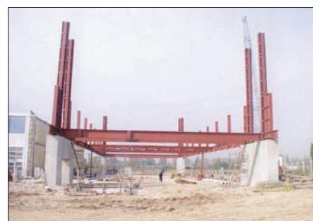
Montaj schelet metalic (grinzi transversale) pe cei 4 piloni de beton armat - corp A
