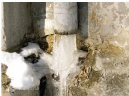
**Foto 5: Aport suplimentar de umiditate în zona burlanelor deteriorate**
