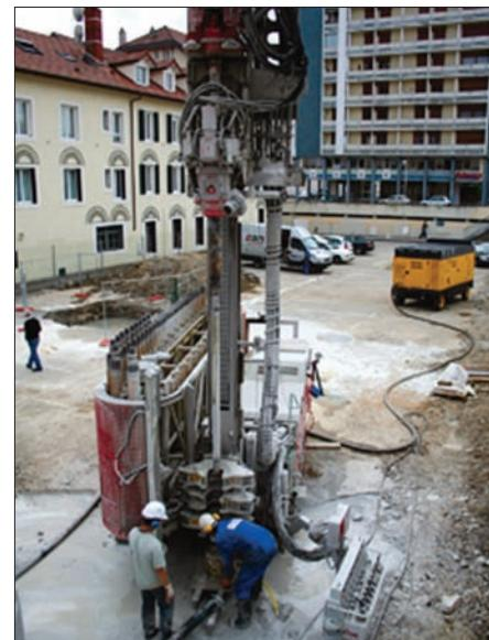
a încărcătorului face noua **foreză MC900GT** mai manevrabilă și, de asemenea, conținând la bord o baterie completă de prăjini, permite reducerea costurilor de transport a echipamentului necesar pentru foraj. **Foreza MC900GT** este ușor (și eficient) manevrabilă de către un singur operator. După cum am demonstrat (în mod sumar), sperăm, că geotermia ar putea aduce o contribuție valoroasă la transformarea sistemului energetic. □
