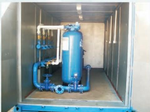
**3. Filtrare pe pat de cărbune activ** - asigură reținerea amoniacului, fierului, a substanțelor organice, a clorului rezidual. Apa trece prin mediul filtrant format dintr-un strat de cărbune activ, așezat peste un strat de nisip selectat (filtre automate cu pat de cărbune activ din seria Aquator Carbon Line).
