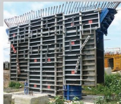
Combinarea sistemului de cofraje MANTO cu sistemul special pentru lateralele curbe a permis turnarea pilelor de pod într-o singură etapă.
