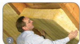
Profilele de metal se fixează prin înțepare. Instalația doilea strat de termoizolație fără goluri folosind produsul Isover DOMO.
