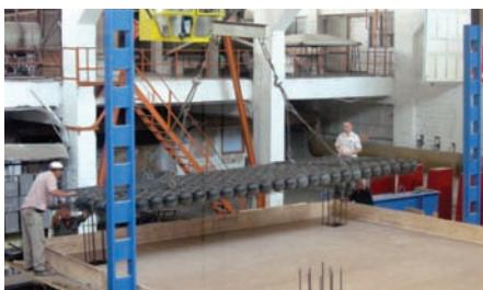
Foto 3: Montaj module Bubble Deck
