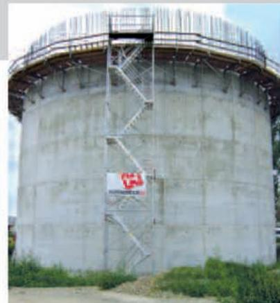
*Rezultatul poate fi observat cu ușurință: Cofrajul circular RONDA a asigurat obținerea unei suprafete de beton de calitate superioară.*
