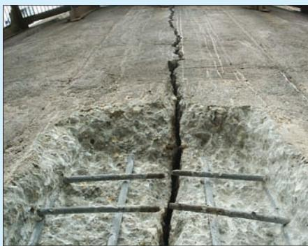
Silozurile de ciment și clincher din cadrul fabricilor de ciment au suferit serioase degradări din cauza subdimensionării la eforturile din temperatură și a neinjectării goulurilor din zona tijelor de glisare.
