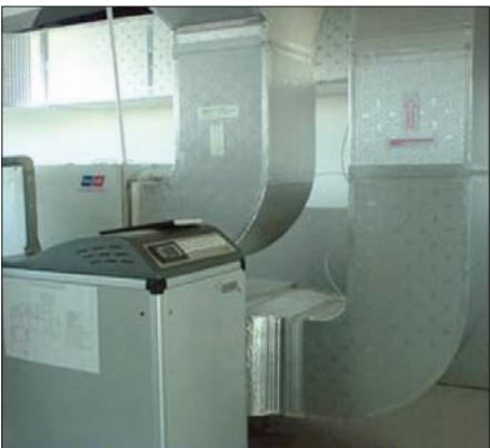
Fig. 5: Sistem de ventilare cu recuperare de căldură
