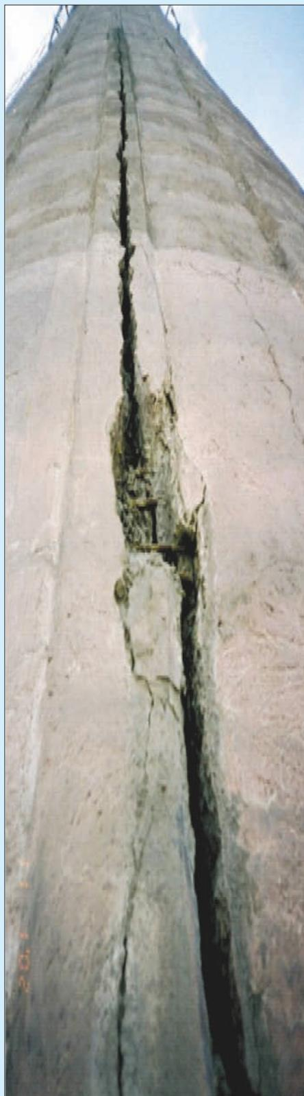
COȘURILE industriale care deservesc sistemul energetic și industria pe diverse ramuri de producție, proiectate și executate în perioada anilor 1970 - 1988, au crăpat pe verticală din cauza dimensionării necorespunzătoare la eforturile din TEMPERATURĂ și a proastei izolații termice și antiacide.
