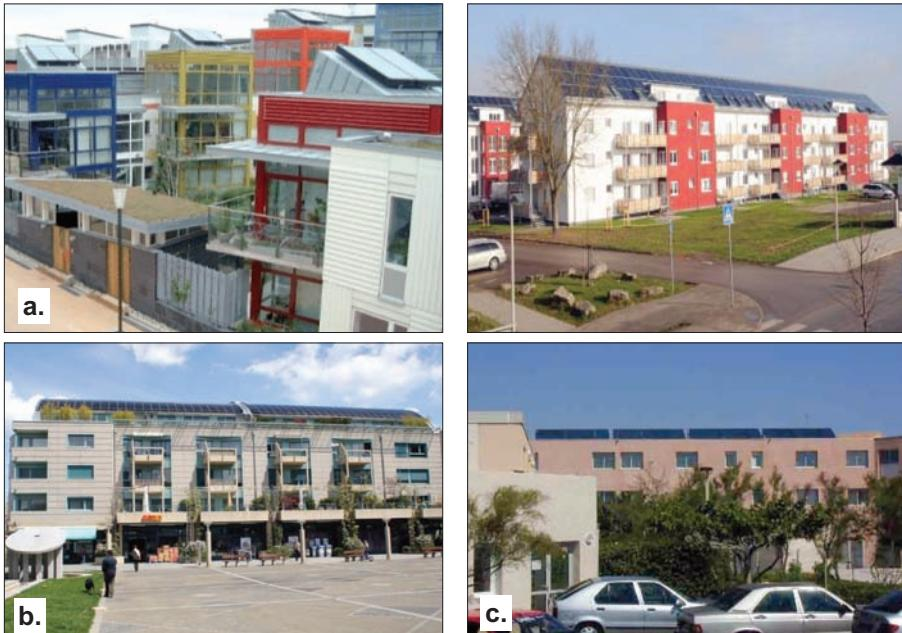
Fig. 5: Panouri solare situate pe acoperișurile înclinate sau curbe ale clădirilor etajate:
