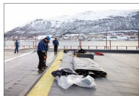
Sistemul introduce un flux de aer controlat sub membrană, prin intermediul unor ventile special proiectate. Datorită principiului de funcționare, stratul suport trebuie să fie etans.
