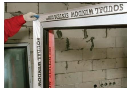
Pentru izolarea exterioară a ferestrei se poate utiliza banda care permite trecerea liberă a aerului **Soudal Folienband Outside** sau banda expandabilă **Soudal Souband Acryl** (foto: Soudal)
