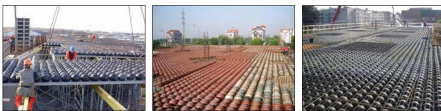
Fig. 9: Aspecte de la punerea în operație a planșeelor COBIAX - BUBBLEDECK
