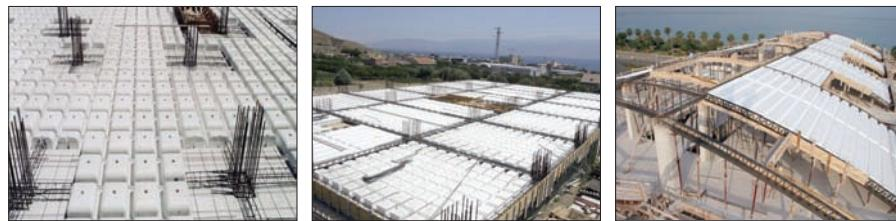
Fig. 14: Aspecte de la punerea în operă a planșeeelor SOLAIO CUBE
