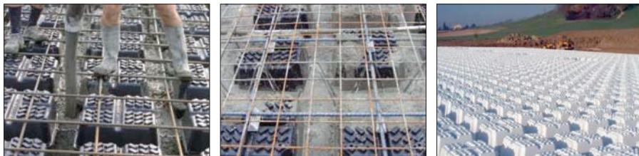
Fig. 12: Aspecte de la turnare beton autocompactant în planșeele U-BOOT
