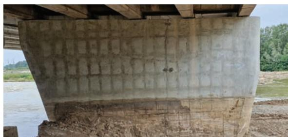
Pila fisurată pe întreaga elevație
