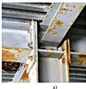
Fig. 8: Întărirea îmbinării grindă-stâlp: (a) poza cu îmbinarea existentă; (b) îmbinarea întărită cu vută și plăci de continuitate
