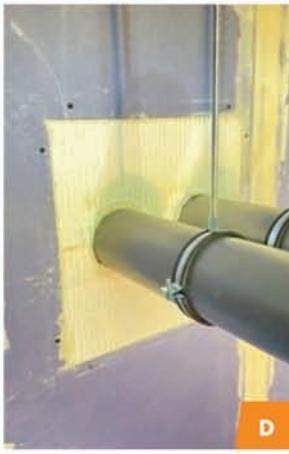
Knauf FPC PANEL se utilizează pentru etanșarea străpușngerilor de dimensiuni medii și mari, cu/fără treceri de conducte din materiale plastice combustibile, conducte metalice cu izolație din materiale combustibile și/sau cabluri electrice (paturi de cabluri) și a rosturilor liniare prin:
