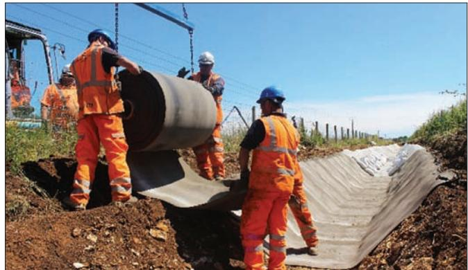
Foto 6: Impermeabilizare rigole
