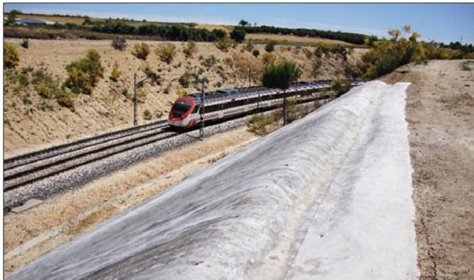
Foto 5: Impermeabilizare rigolă la partea superioară și control erozional
