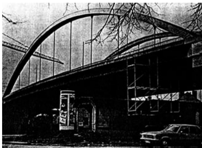
Fig. 1.31: Pasajul Dortmund – Mengede. Vedere generală
