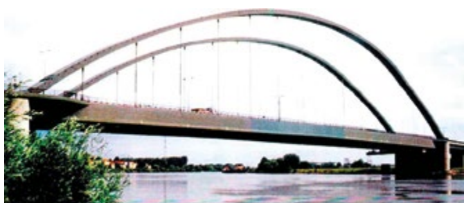
Fig. 1.34: Podul Regensburg – Schwabelweis. Vedere generală
