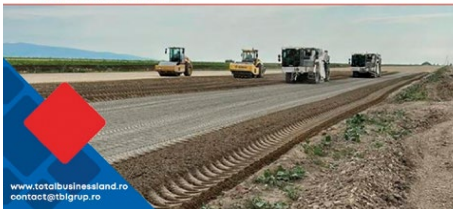
Foto 1: Autostrada A7, Lot 1 – Lucrări de execuție în desfășurare, iulie 2023
