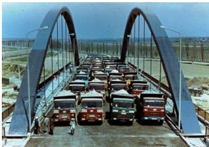
Fig. 1.104: Încercare „in situ” tablier Langer
