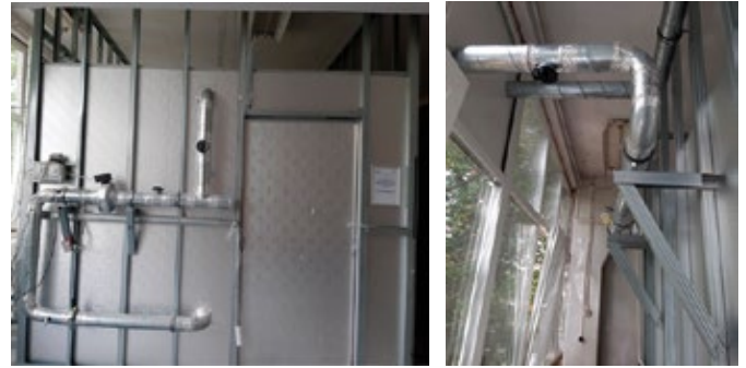
Fig. 8: Stand experimental S2 – vedere frontală și laterală
