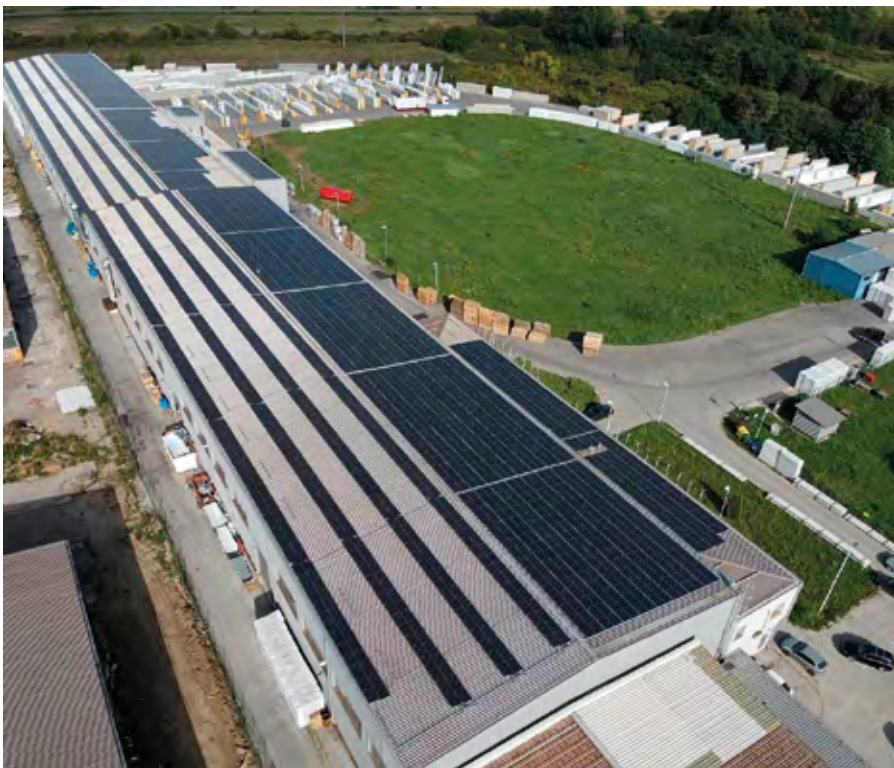
Fabrica de panouri termoizolante din Leskovac, Serbia
