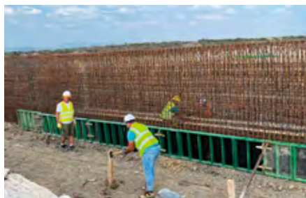
Foto 1: Autostrada A7, Lot 1 – Lucrări de execuție a podețelor, august 2023
