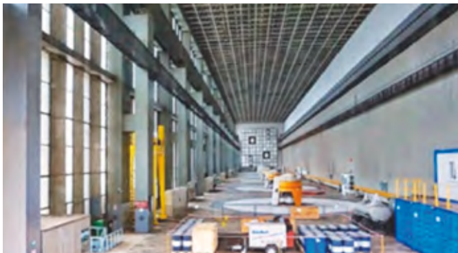
Sala mașinilor de la CHE PF I, cu structura reticulată a acoperișului, sistem care se aplica în premieră în România, și podul rulant de 400 t, cel mai mare din țară
