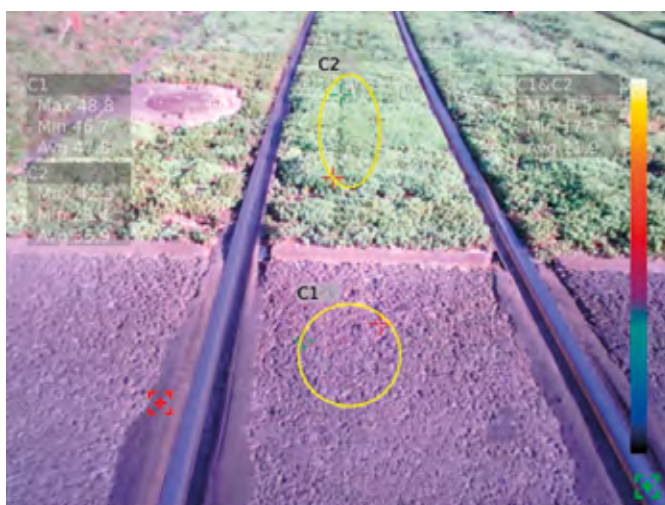
Diferența de temperatură între zonele urbane construite și zonele cu vegetație verde poate fi semnificativă, mai ales în condiții de vreme extrem de caldă – testare cu camera cu termoviziune în zona liniilor de tramvai – Arad, 23.08.2023
