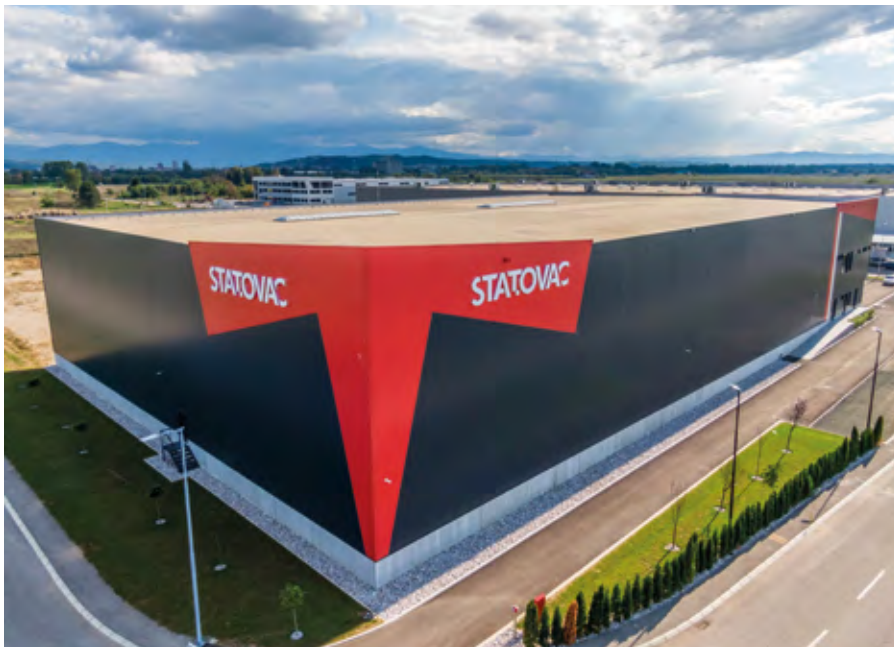
Proiect complex de reconstrucție: Centrul logistic Statovac, Leskovac, Serbia
