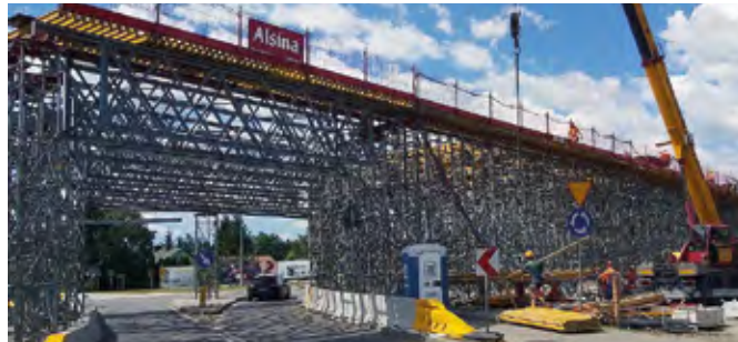
Extinderea liniei de cale ferată 25 Łódź - Dębica (Polonia)
