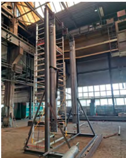
Fig. 12: Suspendarea BRB-urilor pentru turnarea betonului
