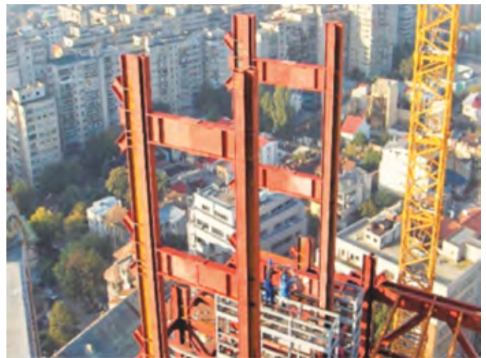
Clădirea Tower Centre International, vedere de ansamblu (sus) și structura în timpul montajului (jos) 25
