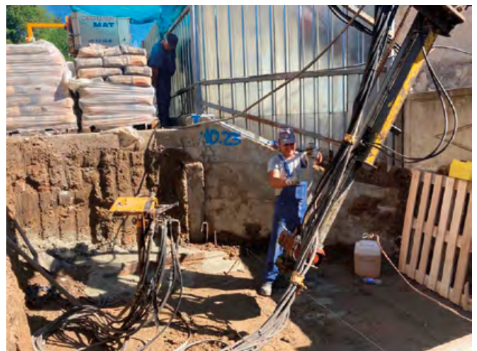
Execuție micropiloți zid de sprijin bază
