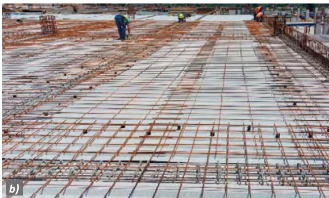
Fig. 5: Menținerea la poziție a armăturilor – a) cu distanțieri metalici; b) cu distanțieri din plastic
