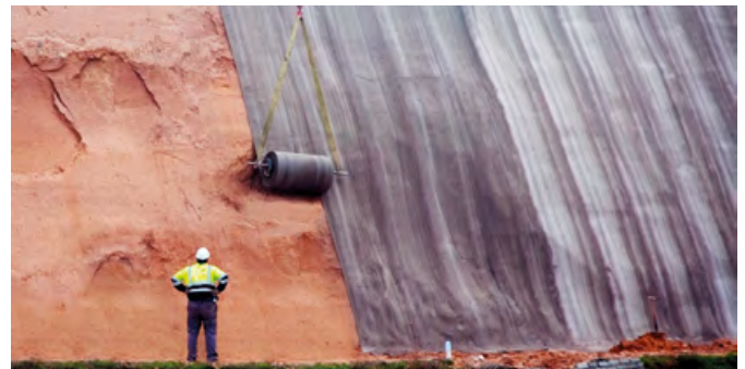
Foto 4: Control erozional
