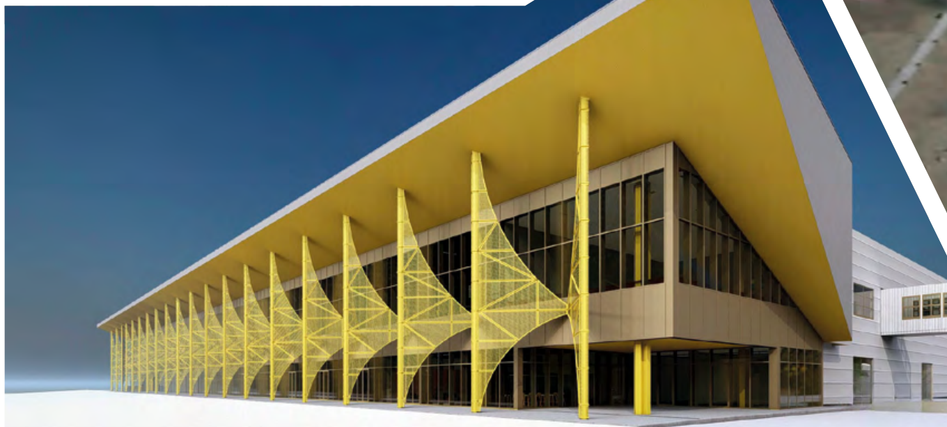
Extindere terminal Aeroportul Internațional Avram Iancu Cluj-Napoca
