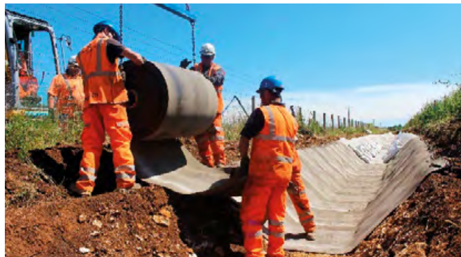
Foto 6: Impermeabilizare rigole
