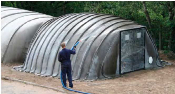
Foto 1: Concrete Canvas® a fost inițial inventat ca strat exterior pentru un adăpost de ajutorare în caz de dezastru
