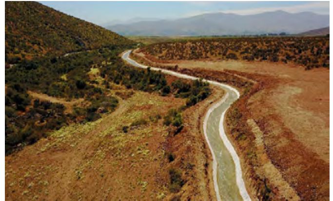
Foto 3: Una dintre aplicațiile de bază pentru GCCM este impermeabilizarea canalelor
