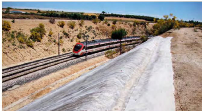
Foto 5: Impermeabilizare rigolă la partea superioară și control erozional
