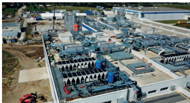
Fabrica P&G Urlați (Sursa: https://syncons.eu/pg-facility )
