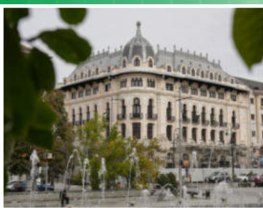
Lucrări restaurare clădire „Palace”
